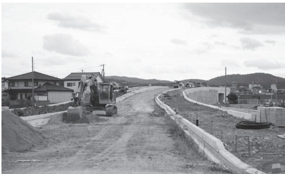
工事の進む都市計画道路 上原願万地線
