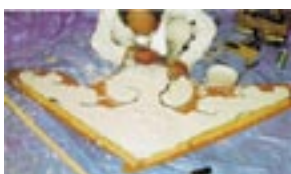
▲棟飾りの製作。棟の先端を風雨から守る部分に装飾を施したもので防火の意から「水」の字をかたどっている。
