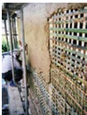
▲木舞(竹とわら縄などで組んだ壁の基礎)に土で下塗りをする工程。木舞のできる職人が減ってきている。
