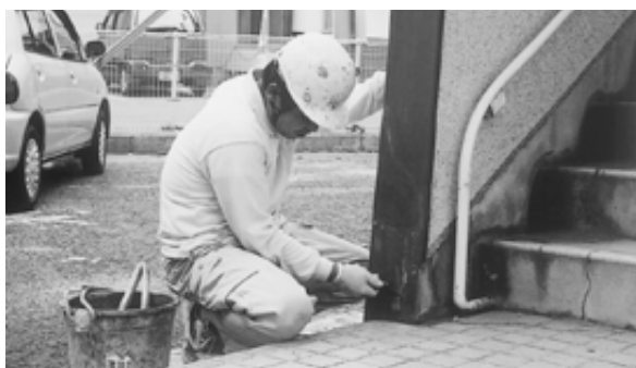
非常階段のひび割れをセメントで補修(東光保育所)
