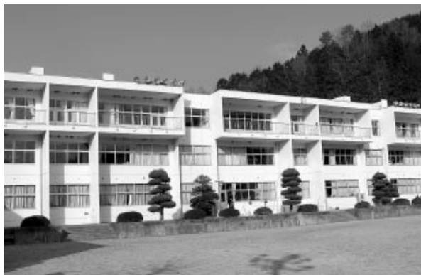
吉舎小学校と甲奴中学校で耐震補強工事を実施 (写真 甲奴中学校)
