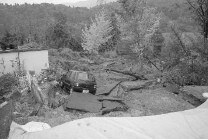
液状化現象で崩れ落ちた道路
