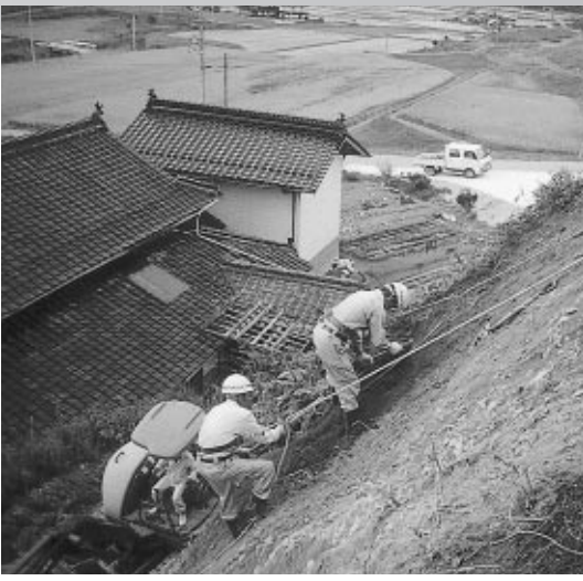
土砂災害の復旧作業（石原町）
