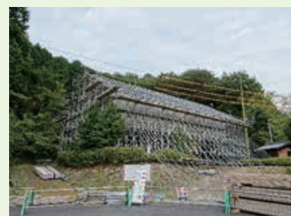
建物の周囲に足場や仮屋根を設置。
