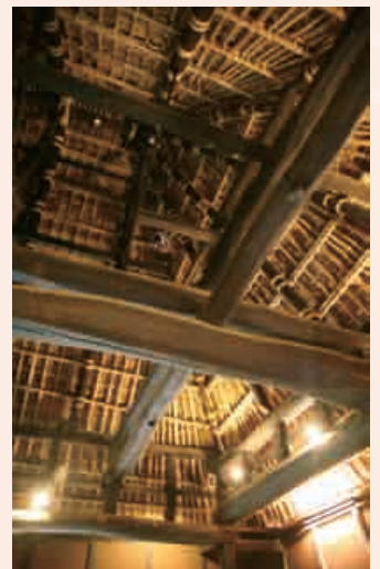
土間から見上げた屋根裏(縦横に5本の梁が組み合わされている)
