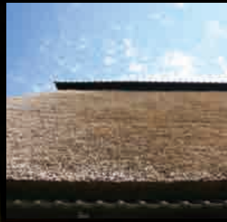
▲ 改修した北側屋根
