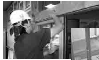
扉の修繕 (さくぎ保育所)
