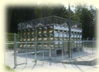
藤谷配水池（三若）
