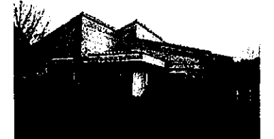
改修予定の田幸保育所
