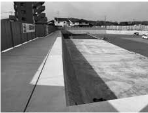
工事中の五龍川貯留施設
