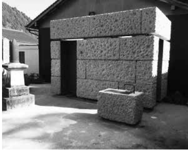
三次町に新設された太歳神社のトイレ
