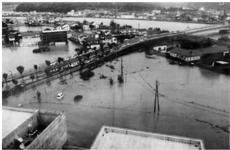
平成30年7月水害（市民ホールきりり屋上から）
