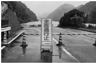
国道375号線作木町下作木式から上流の冠水状況
