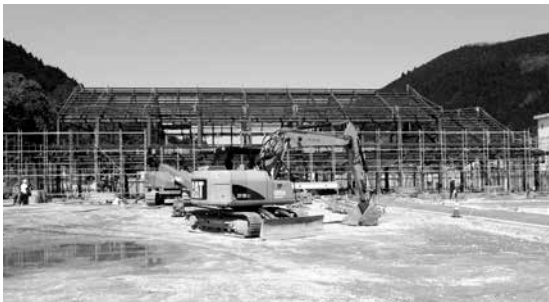
建設中の三次もののけミュージアム
