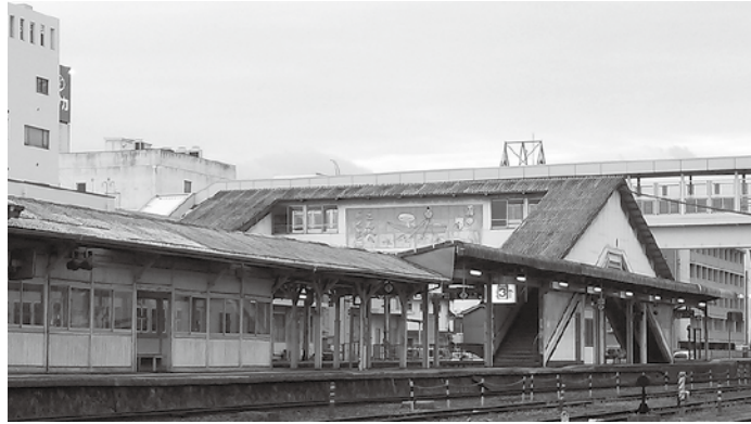
三次駅跨線橋
