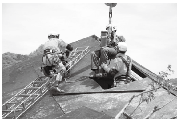
平成27年に実施された総合水防演習
