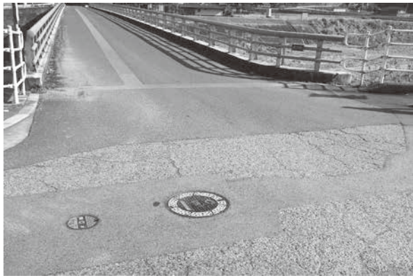
水道新設箇所（西河内）
