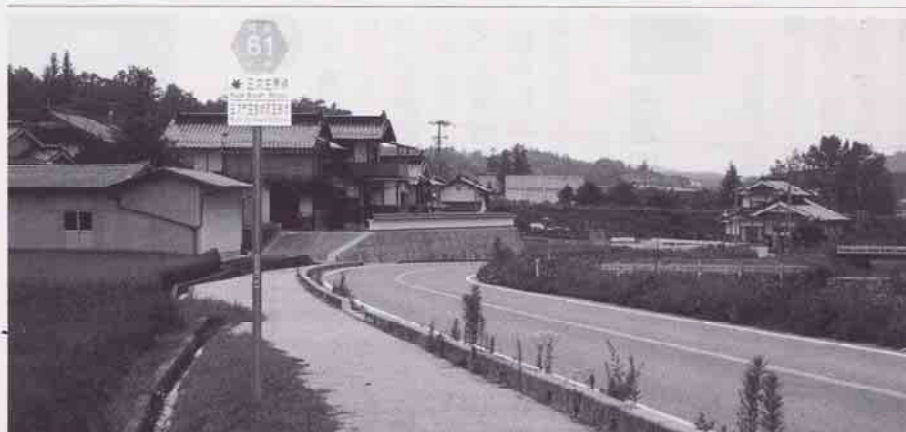
県営事業の県道三次庄原線（三良坂町）
