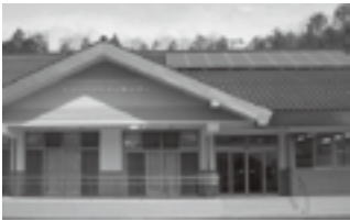
太陽光発電設備のある青河コミュニティセンター
