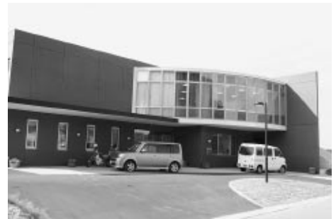
10月1日にオープンしたケアハウス吉舎
