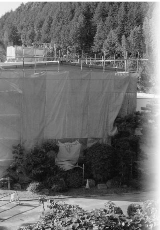
甲奴中学校大規模改造工事(耐震補強)
