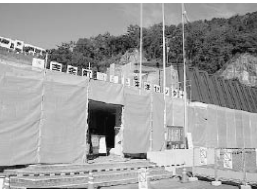
アスベスト除去を含む改修工事が進むB&G吉舎海洋センター
