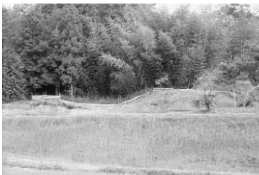
有害鳥獣被害対策のため設置された柵 (向江田町)
