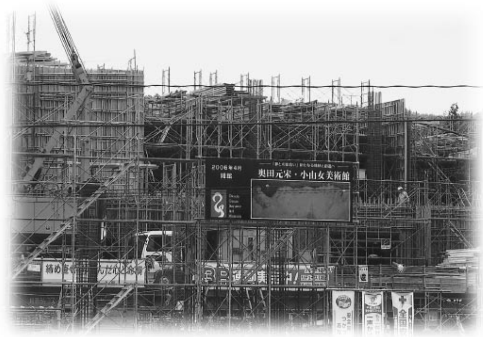
建設が進む奥田元宋・小由女美術館
