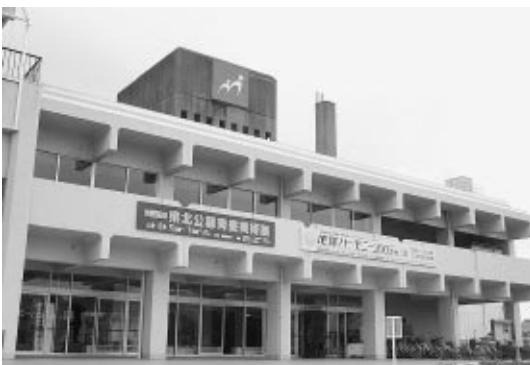
制度導入が検討されている施設の1つ 三次市文化会館
