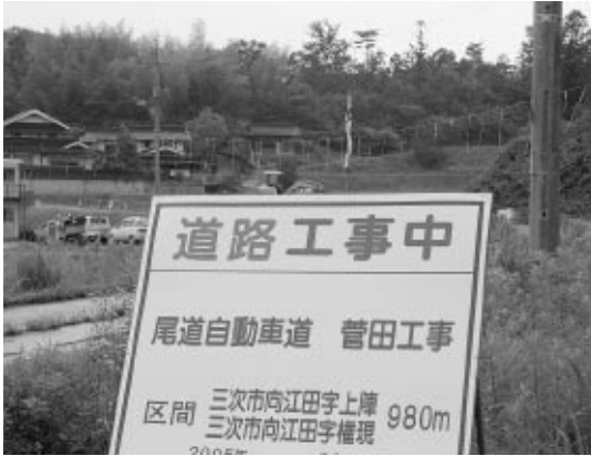
中国横断自動車道 菅田工事
