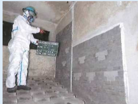
焼却炉補修後
