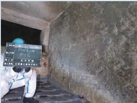
焼却炉補修前
