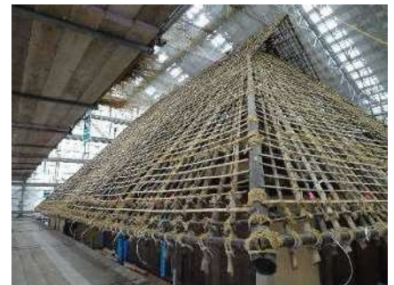
修理中の様子（幡山家住宅）
