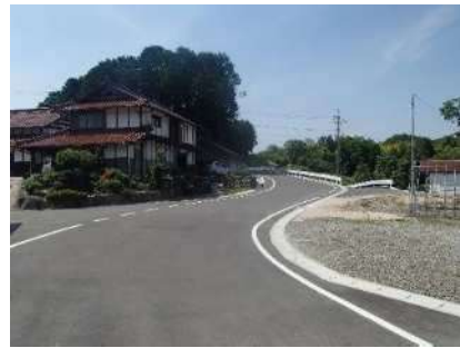
道路拡幅（市道穴笠畠敷線）
