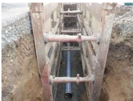
開削管渠布設工事（三次町）
