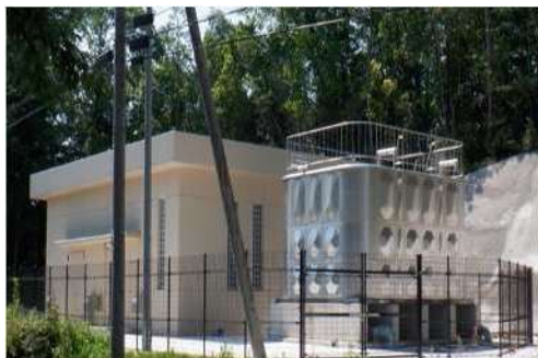
ポンプ所の整備（和知ポンプ所）
