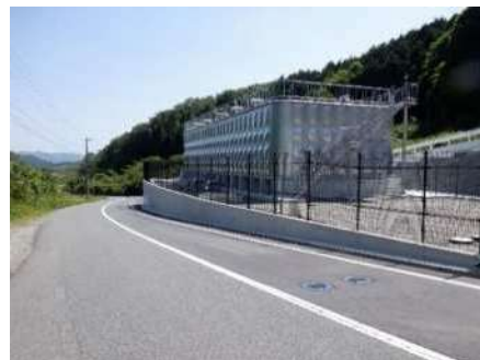
配水池の整備（八次配水池）
