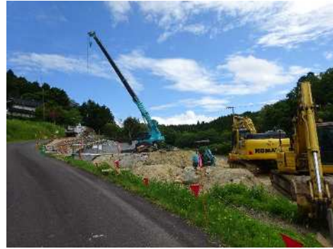
配水池の整備（八次配水池）
