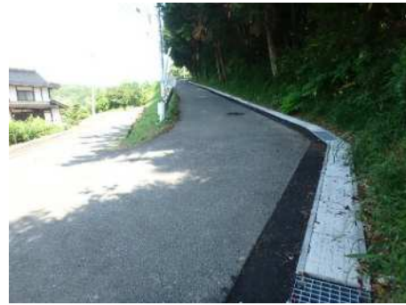
側溝蓋修繕による歩きやすい歩道整備 (市道三五 320 号線)
