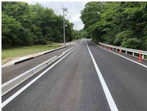
道路拡幅（県道羽出庭三良坂線）
