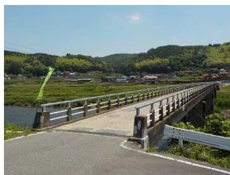
橋梁長寿命化に基づく整備 市道河内59号線（穴笠橋）
