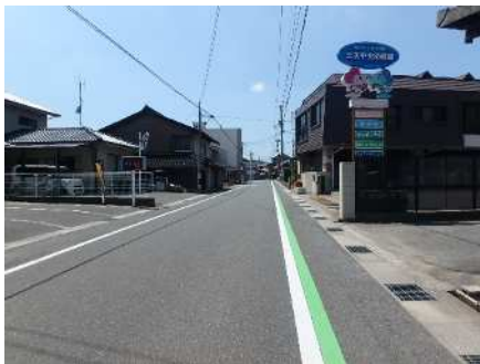
路肩部へのカラー舗装 （市道十日市 14 号線 十日市小学校区）
