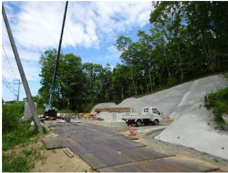
ポンプ所の整備（和知ポンプ所）
