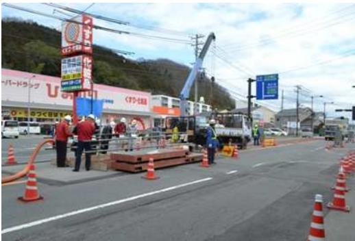
推進管渠布設工事（三次町）
