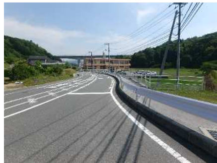
ガードレールの設置 （県道和知塩町線 和田小学校区）
