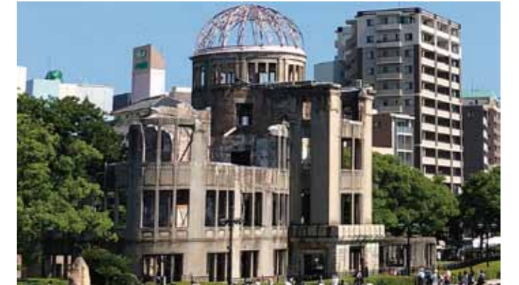
原爆ドーム(旧広島県産業奨励館)(広島県広島市)
