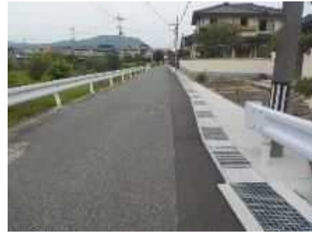
側溝蓋修繕による歩きやすい歩道整備 （市道胡子坂根線）
