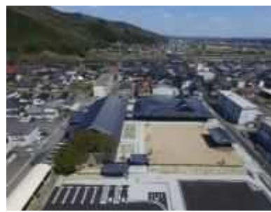
三次地区拠点施設建設状況 (平成 31 年 4 月 15 日現在)
