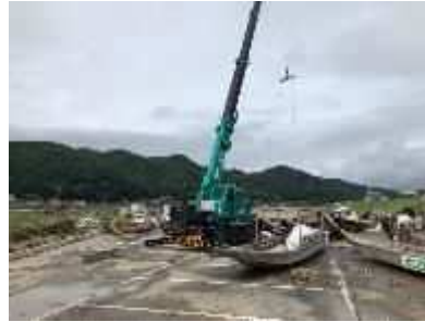
災害復旧作業の様子
