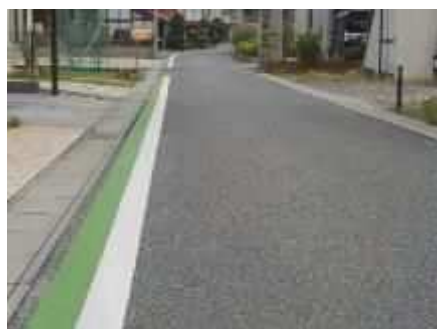
路肩部へのカラー舗装 （市道八次136号線 八次小学校区）
