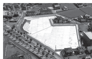
五龍川貯留施設 令和4年8月完成
