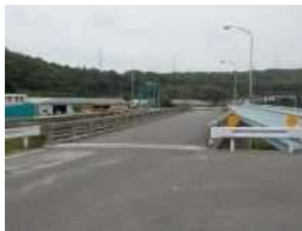
橋梁長寿命化に基づく整備 市道三良坂462号線（国光橋）
