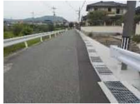
側溝蓋修繕による歩きやすい歩道整備 （市道胡子坂根線）
