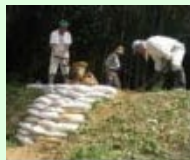
漏水箇所の補修
