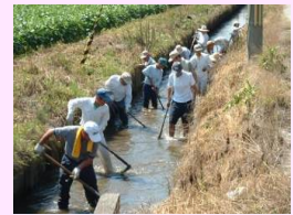
水路の泥上げ
