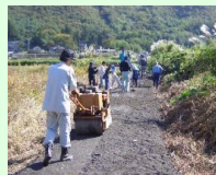
未舗装農道の舗装
