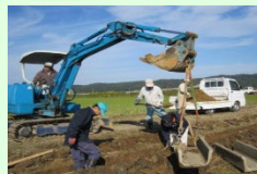
コンクリート水路の更新
