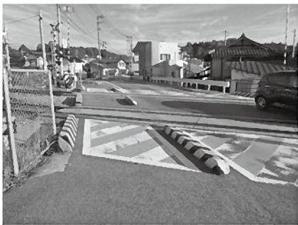
中原踏切（十日市南）
