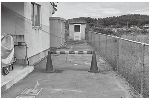
園児の安全対策（応急措置）がとられた保育所
