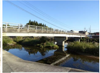
新記念橋 L=86.8m(PC橋) 1980年架設
