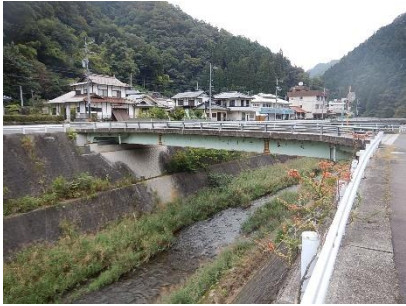
湊新橋 L=27.4m(鋼橋) 1987年架設
