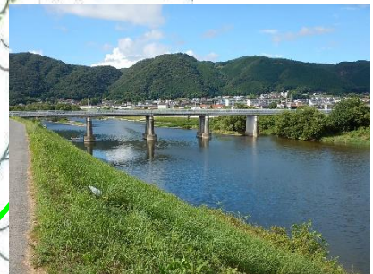
鳥居橋 L=214.6m(RC橋) 1938年架設
