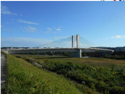
願橋 L=181.0m(PC橋) 2012年架設
