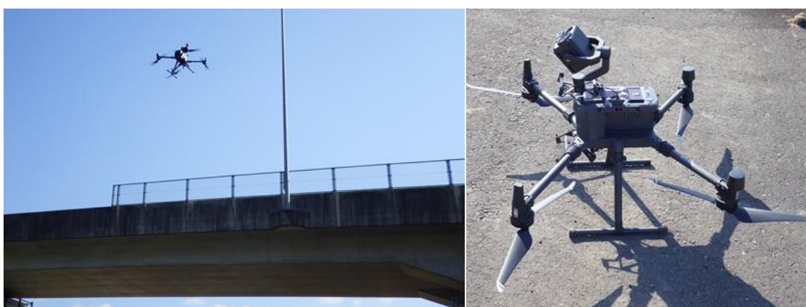
橋梁定期点検状況
