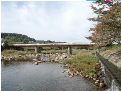
三ツ又橋 L=53.6m(鋼橋) 1973年架設
