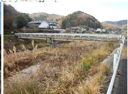
国広橋 L=37.1m(鋼橋) 1969年架設
