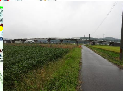
神杉跨線橋 L=138.0m(PC橋) 1981年架設
