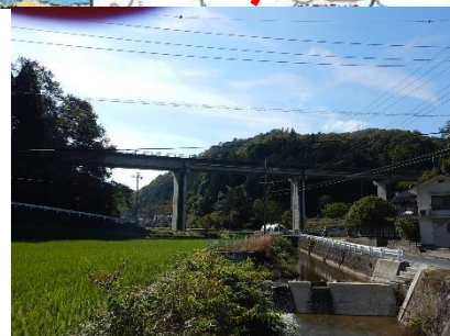
矢井大橋 L=160.0m(PC橋) 1994年架設
