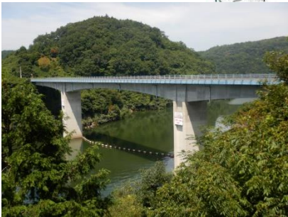
灰塚大橋 L=180.0m(PC橋) 2000年架設
