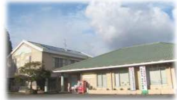
■ 避難所に設置した太陽光パネル ■
