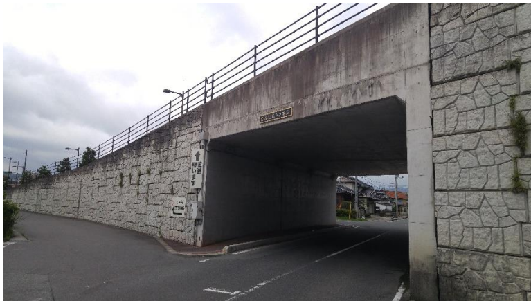
図 1-2 三次市が管理する大型カルバート
