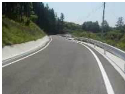
道路拡幅（市道穴笠畠敷線）
