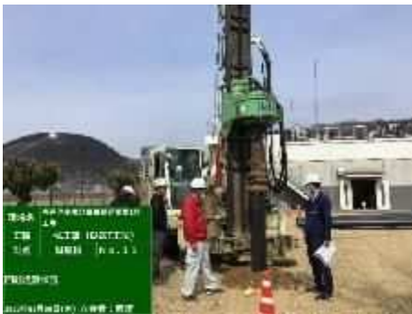
基礎杭打設（三次町）
