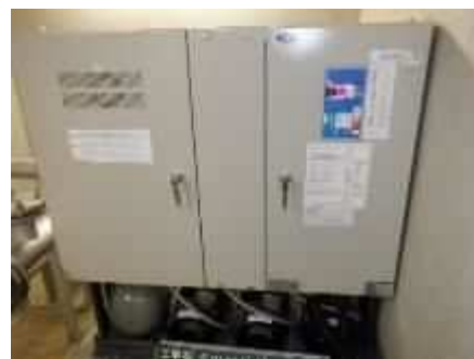
丸田加圧ポンプ所の給水ポンプの更新（吉舎町）
