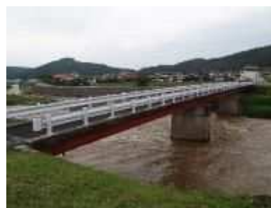
橋梁長寿命化に基づく補修 市道川地24号線（大船橋）
