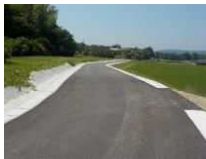
道路拡幅（市道八次70号線）
