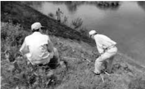
堤防点検の状況
