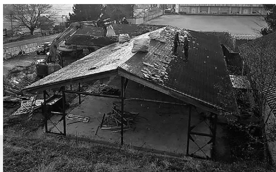
解体が進む公共施設
