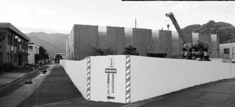
吉舎町拠点施設を整備後、既存の施設(写真左側)は解体します
