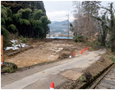
解体・廃止を進めます
