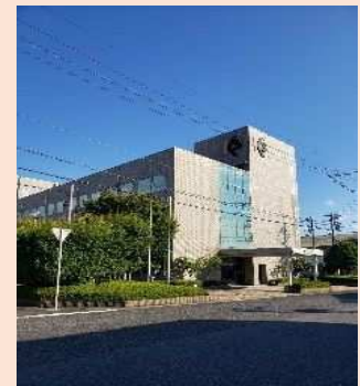
自治体クラウドデータセンター
