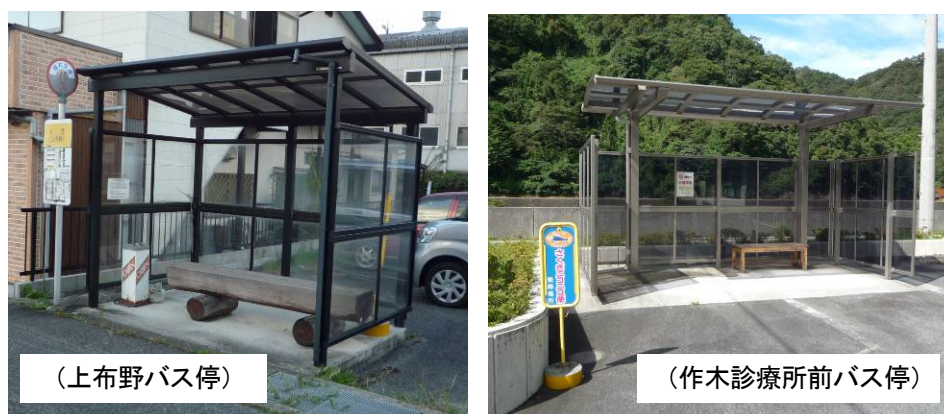
図 3-4 バス停留所への上屋整備
