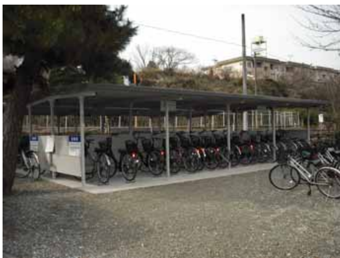
図 5-19 JR八次駅駐輪場の整備(太陽光による夜間照明設置を含む)
