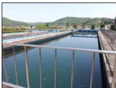
向江田浄水場（薬品沈澱池）
