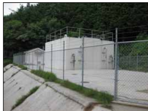
辻・徳市配水池
