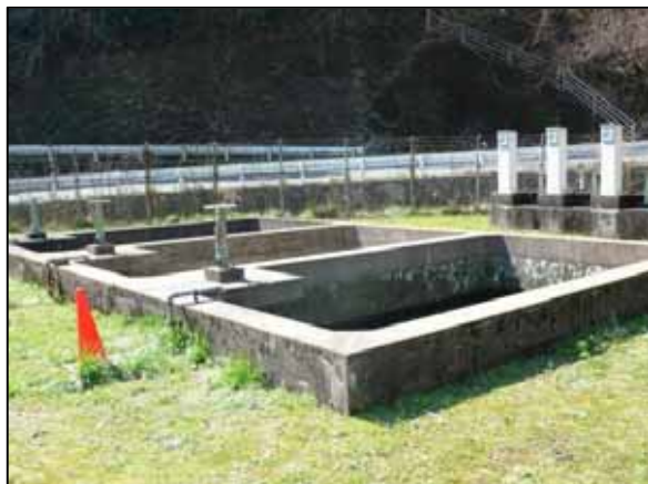
港浄水場(緩速ろ過池)
