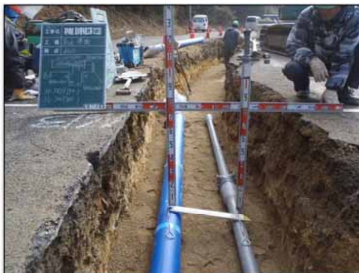
(左) 配水用ポリエチレン管、(右) (耐震管) GX型ダクタイル鋳鉄管
