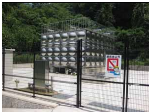
作木第1配水池(外観)
