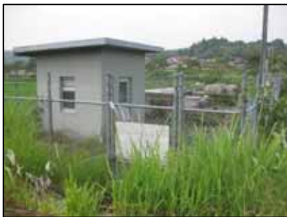
日南取水場(外観)
