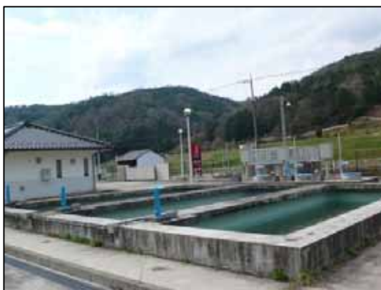
橋本浄水場(緩速ろ過池)
