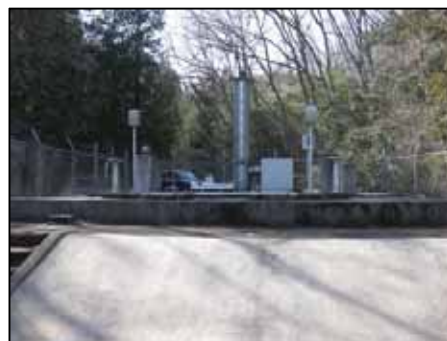
藤兼浄水場(上向き緩速ろ過池)
