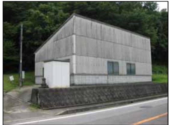
下板木浄水場建屋(外観)
