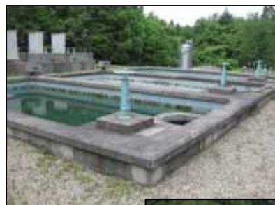
灰塚浄水場(緩速ろ過池)
