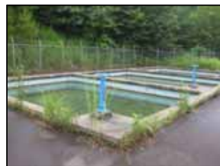
板木浄水場(緩速ろ過池)
