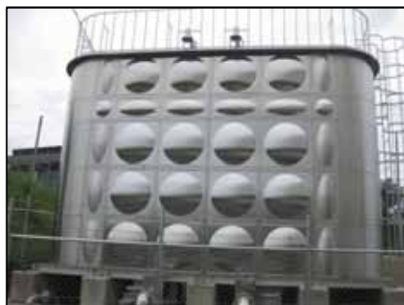
高区配水池(更新後)
