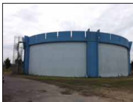
寺戸浄水場(低区配水池)
