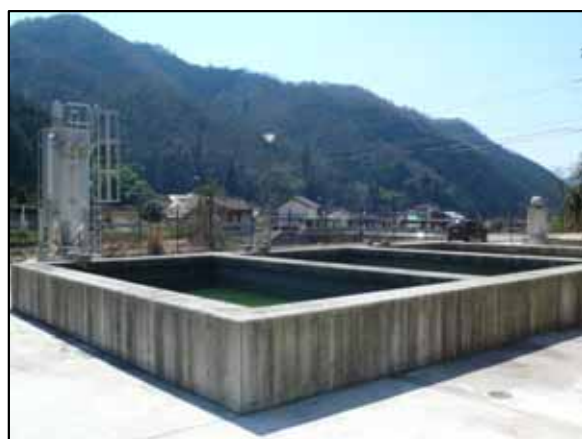
上作木浄水場(緩速ろ過池)
