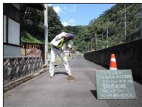
調音による漏水調査(漏水探知機)
