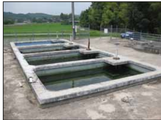
敷地浄水場(緩速ろ過池)
