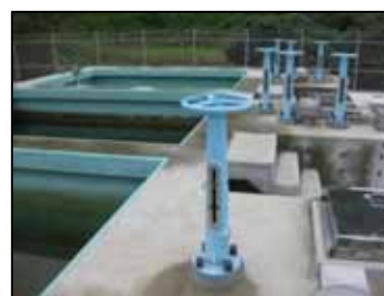
辻・徳市浄水場(緩速ろ過池)
