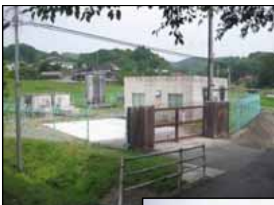
仁賀浄水場(外観)
