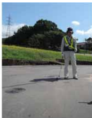
漏水探知機による調査 管路上路面に対し、漏水探知機を用いて音聴し、漏水の有無を確認します。
