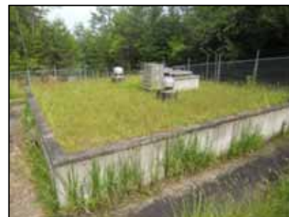
日南浄水場(日南配水池)
