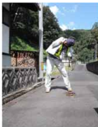
音聴棒による調査 道路上の仕切井や消火栓に対し、音聴棒を用いて音聴し、漏水の有無を確認します。
