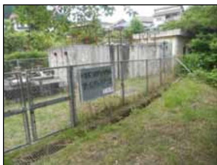
敷名浄水場(外観)(更新前)
