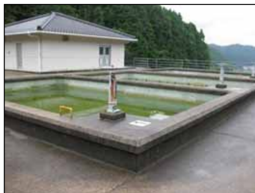
吉舎第2浄水場(緩速ろ過池)
