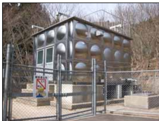
茂田浄水場(配水池)
