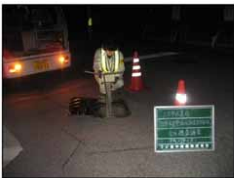
音圧・水圧測定による漏水調査
