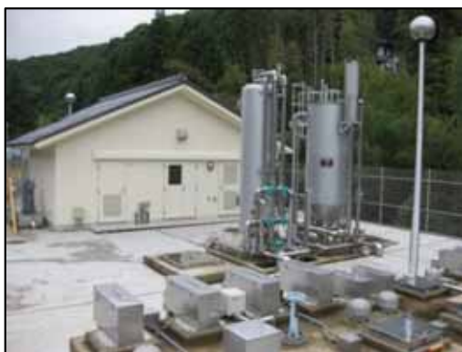
辻・徳市浄水場(外観)
