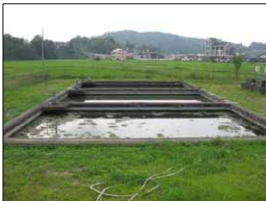
上郷浄水場(緩速ろ過池)
