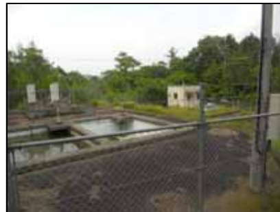
日南取水場(外観)
