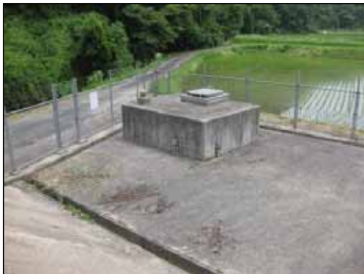
敷地浄水場(敷地水源)
