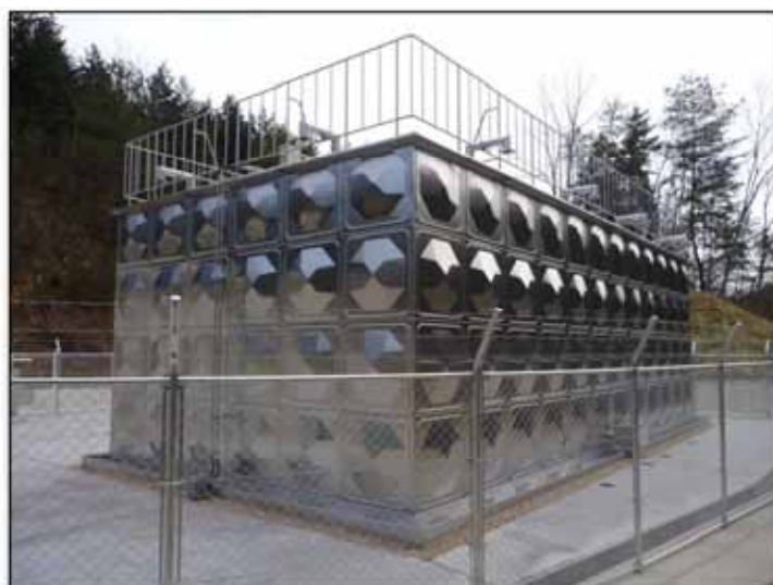
河内配水池(SUS製 耐震性配水池)
