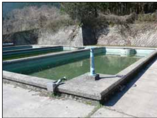
大仙浄水場(緩速ろ過池)
