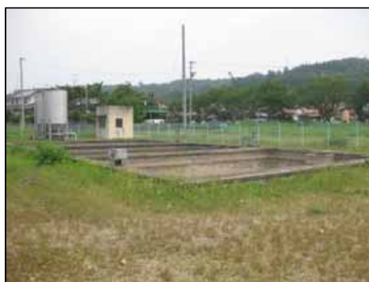
下郷浄水場(緩速ろ過池)
