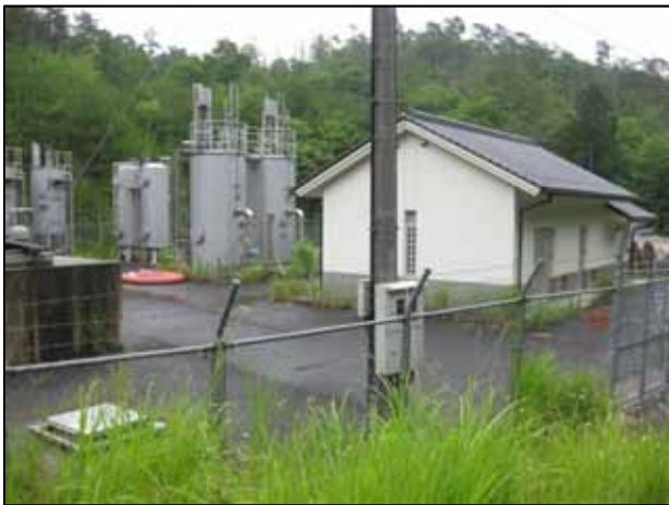
板木浄水場(外観)
