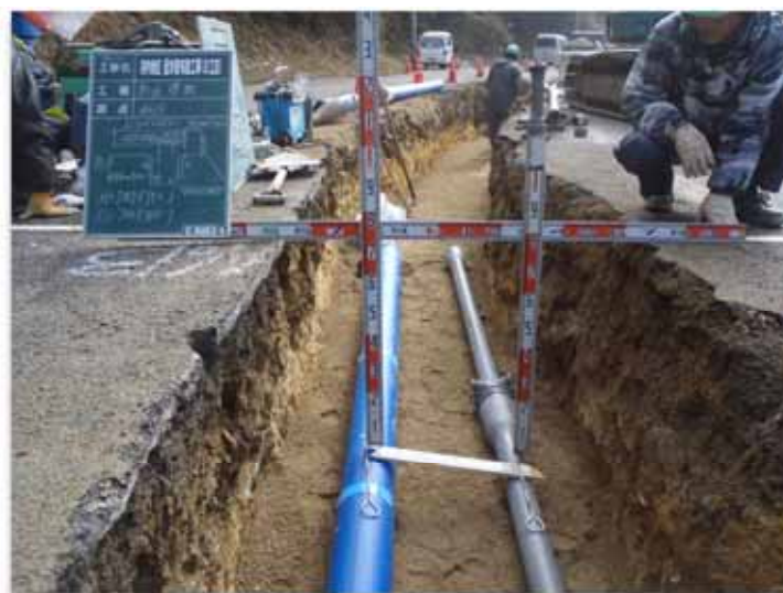
耐震管の布設工事
