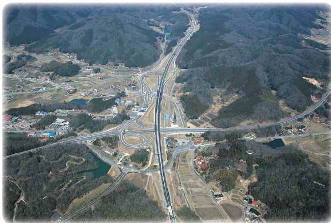
中国横断自動車道尾道松江線三次東JCT
