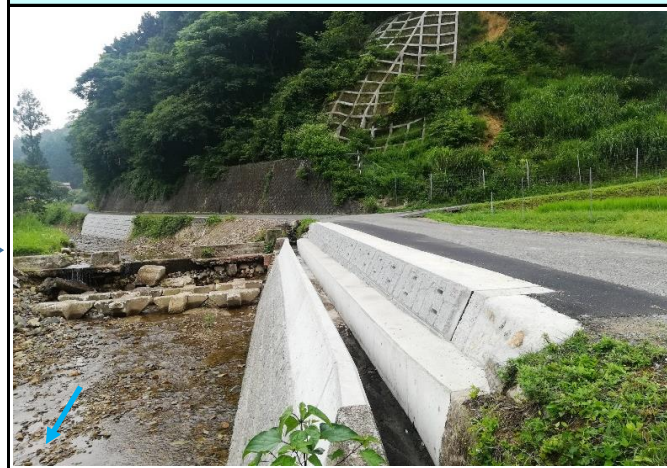
③復旧完了
