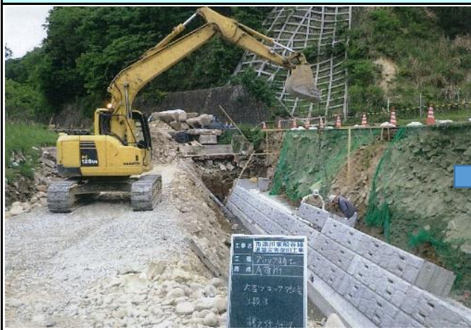
②復旧工事状況
