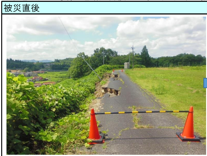
市道八次90号線 道路災害復旧工事（三次市四拾貫町）
