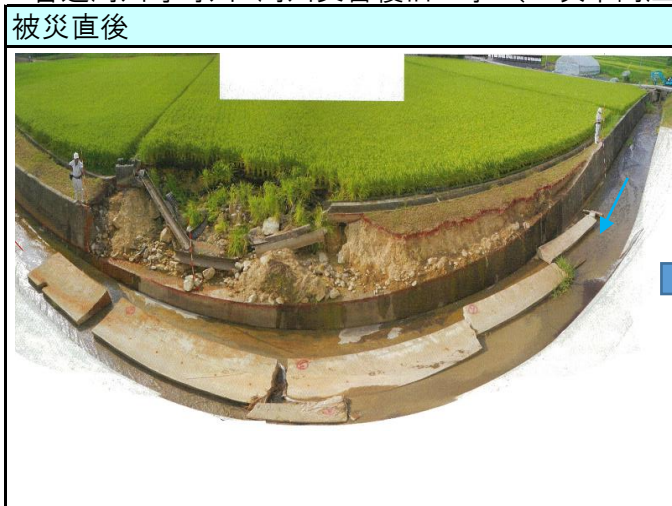
普通河川寺町川 河川災害復旧工事（三次市向江田町）
