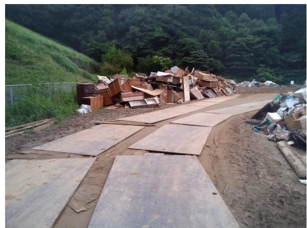
(土のグラウンドを利用した例 要敷き鉄板)
