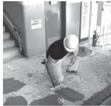
床の修繕(東光保育所)
