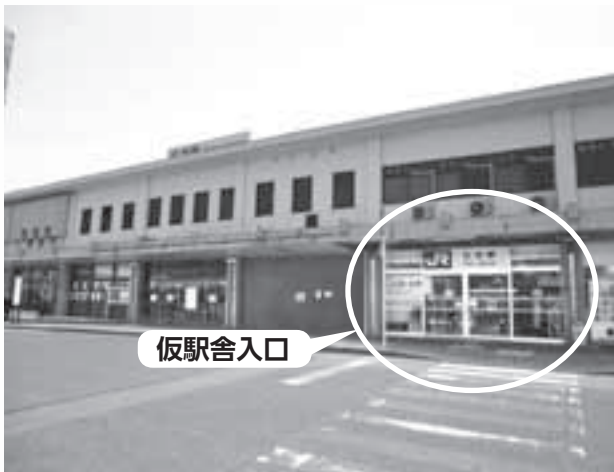
JR三次駅舎の仮駅舎
