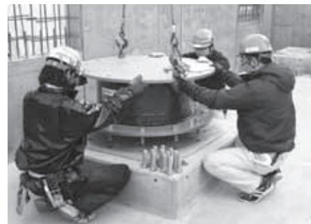
免震装置(積層ゴム)据付
