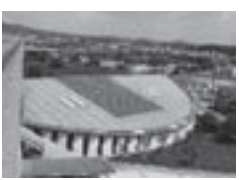
太陽光パネル (市立図書館)
