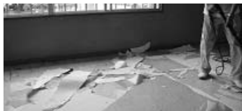
床の張り替え(東光保育所)
